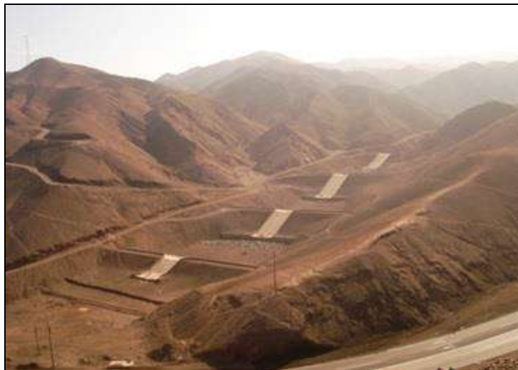
Fig. 3. Obras de mitigación de flujos de detritos en la quebrada del Carmen.
