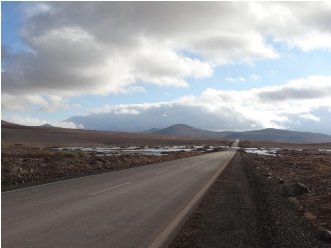
Fig. 1. Tramo inundado por paso de flujo de agua y barro en sector Agua Verde.
