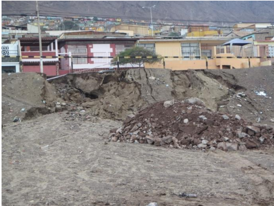
Fig 12. Material antrópico descargado por camiones en zonas afectadas por flujos.
