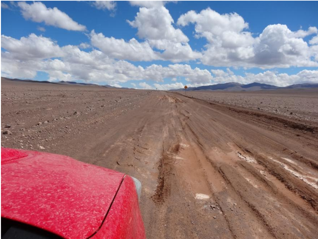
Fig. 5. Acumulación de sedimentos en sectores de la ruta B-800.
