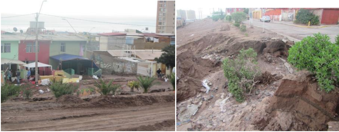
Fig. 15. Viviendas afectadas por flujo en av. Antihue y con calle Colihue.
