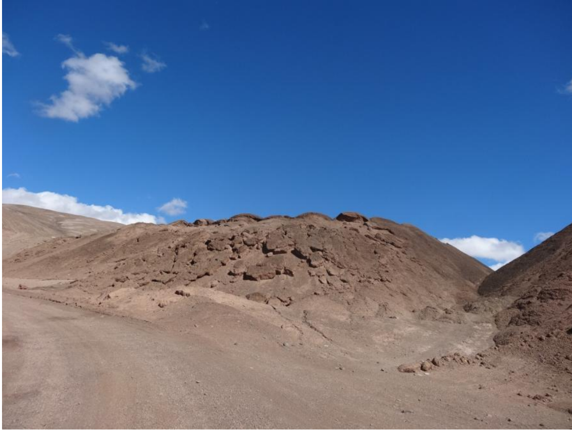
Fig. 7. Deslizamientos superficiales en botaderos abandonados.
