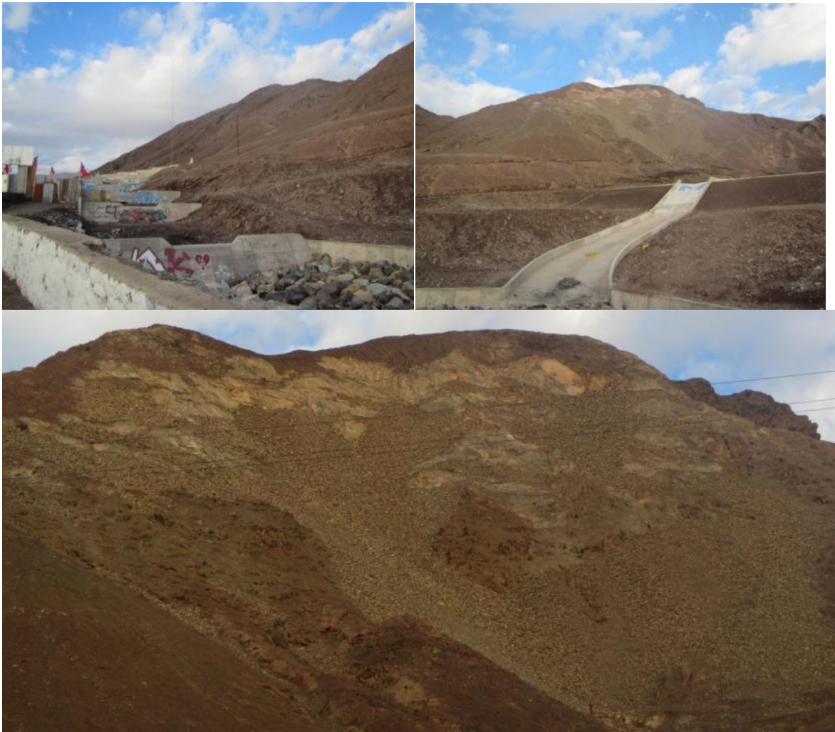
Fig. 14 Arriba: Piscinas en quebrada El Ancla. Abajo: Superficies de deslizamientos planares en roca, con material detrítico aportante a la quebrada El Ancla.
