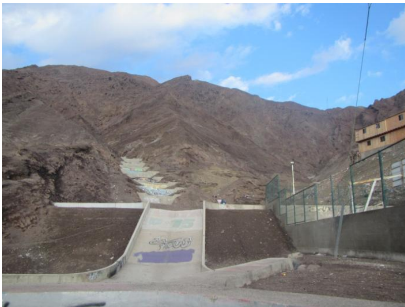
Fig 13. Sistema de piscinas aluvionales en quebrada Baquedano
